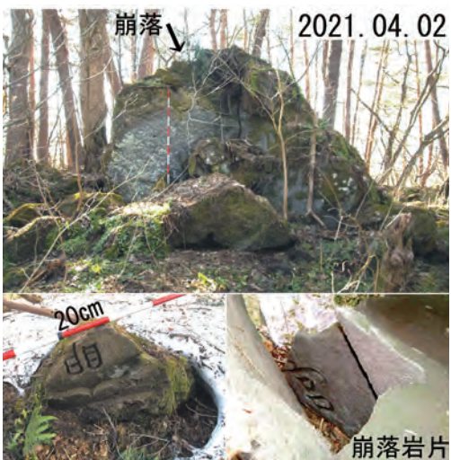
写真4 明治神宮の現状と飛散した岩片 刻字「明治神宮」の部分が崩落し飛散している(2021年4月2日・7日撮影)
