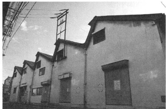
写真1 北側に窓を持つ鋸屋根工場（2013年）
