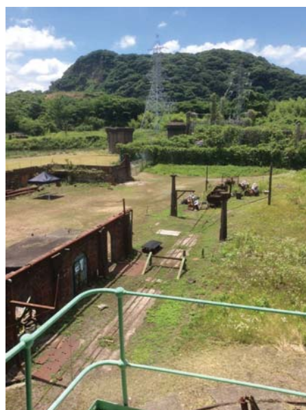
図6 万田坑跡（第二縦坑巻上機室より）
