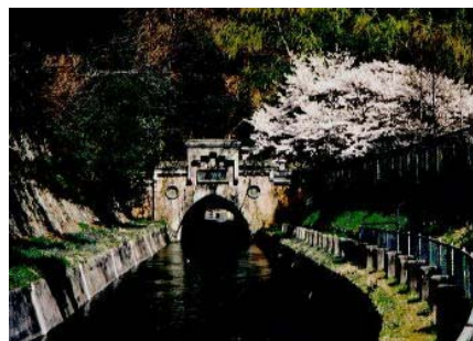
第2トンネル西口
