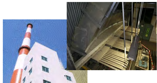
図11 左：中央エネルギーセンターと煙突（稼働中）、右：操業開始当時の石炭燃焼ボイラー（現在は稼働していない）。
