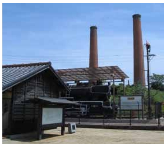
図 3 二本煙突と復元された炭鉱住宅
